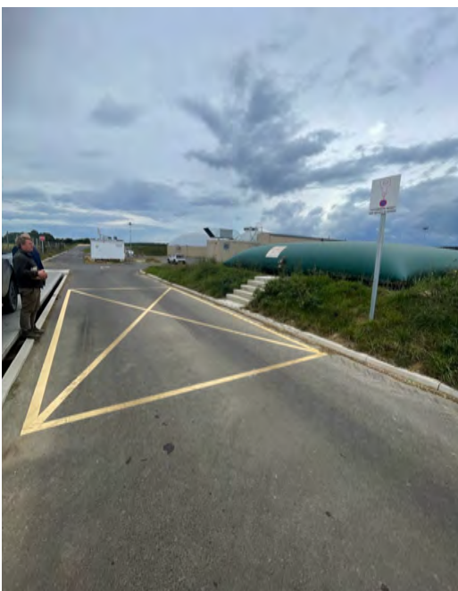
Figure 9. Réserve incendie et plateforme d'aspiration de la SAS TERRE&GAZ
